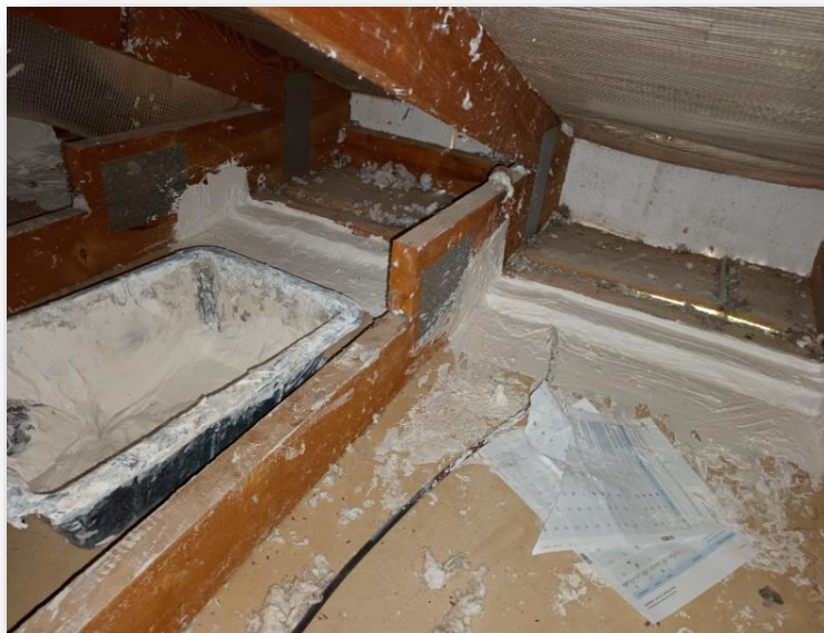
Figure 8 : Exemple du traitement de l'étanchéité à l'air entre la contre-cloison brique et le comble perdu (source Dorémi)
