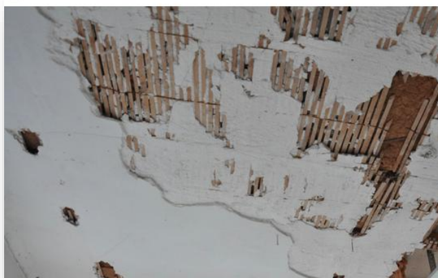
Figure 7 : Exemple plâtre sur lattis non étanche, à reprendre (source : Dorémi)
